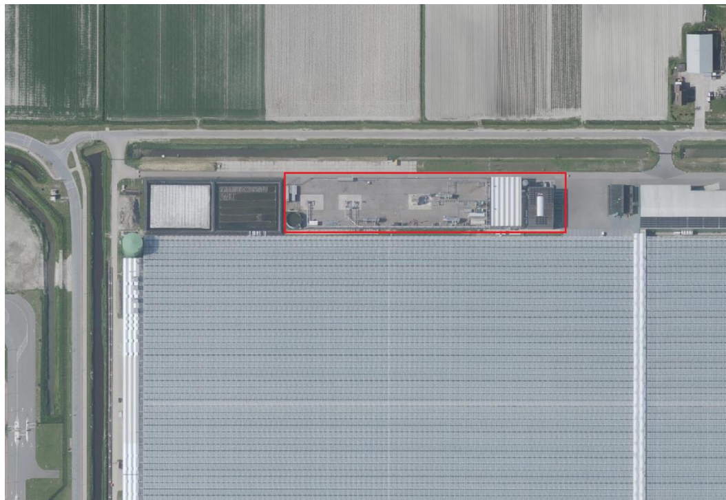
Figuur 2a. Bestaande locatie waarop diepboring wordt uitgevoerd en omgeving van de locatie.
