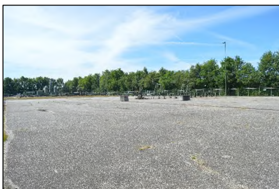
Afbeelding 2.5. Asfaltterrein waar put geboord wordt.
