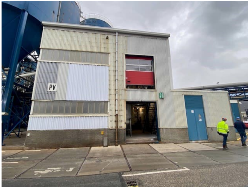
Foto bestaande westgevel PV-gebouw.
