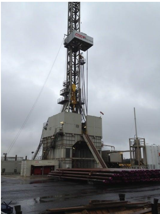
Figuur 4-2: Impressie van de boorinstallatie op de locatie tijdens de boorwerkzaamheden
