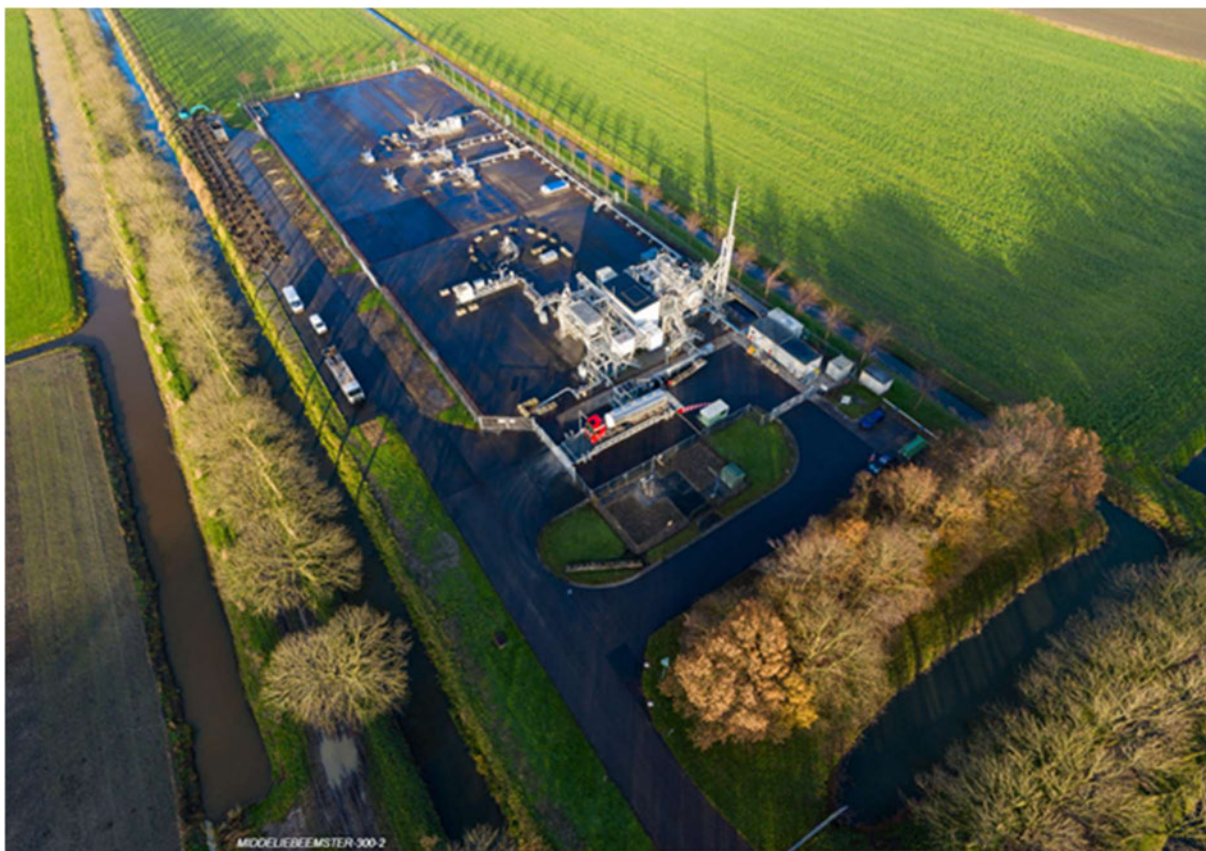
Figuur 3-3: De Middelie-Beemster-300 puttenlocatie en behandelingsinstallatie.
