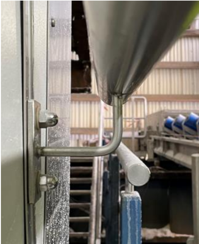
Foto wandleuning in de leidingbruggen
