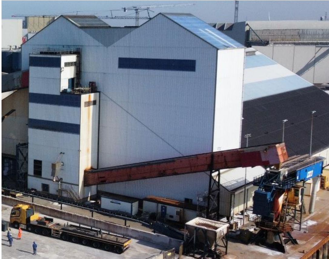
Foto bestaande bandenbrug nr. 3
