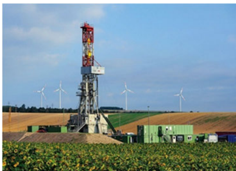
Figuur 5-2: Tijdelijke boorinstallatie.
