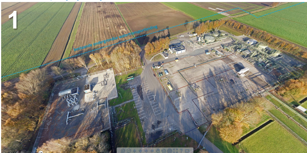
Huidige situatie (VOOR ombouw)
