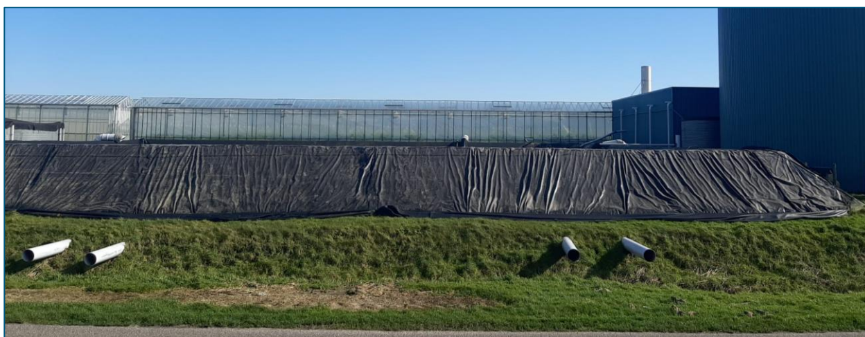
Figuur 2-9. Het waterbassin dat gebruikt wordt voor het opvangen van regenwater en op de achtergrond een deel van de kassen die tijdelijk worden verwijderd om de diepboring mogelijk te maken (locatie 3). Foto: Royal HaskoningDHV, 2022.
