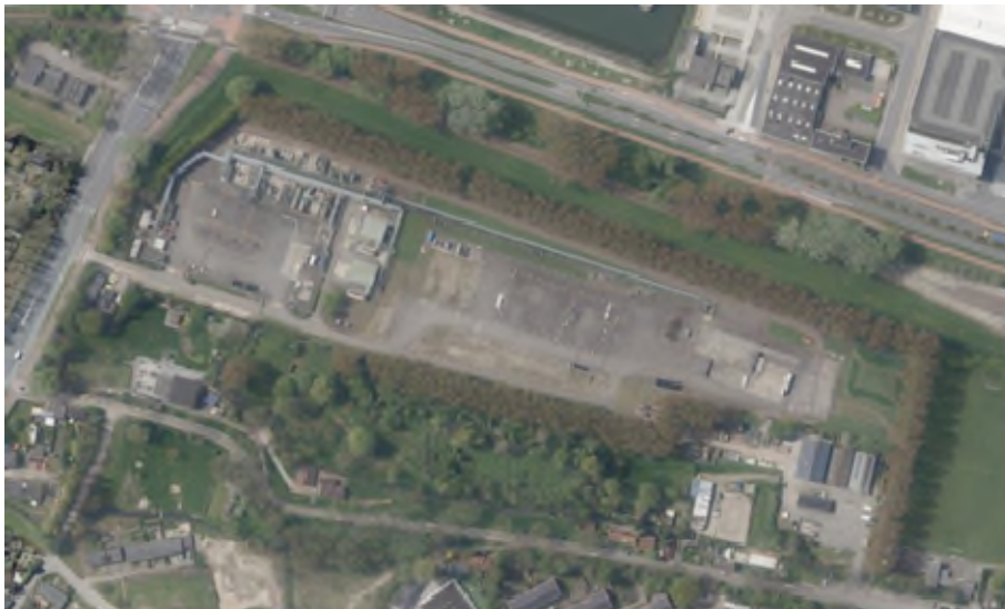
Figuur 2.1: NAM-locatie Rotterdam Meetstation-1
