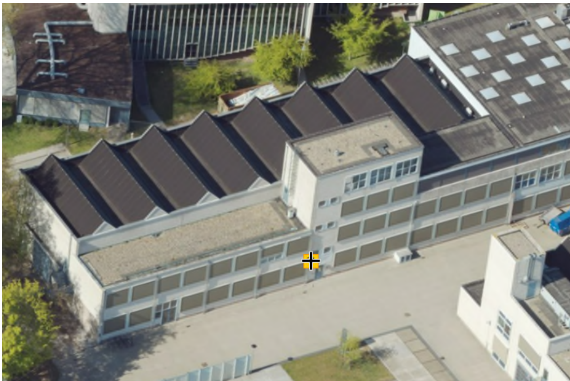
Afbeelding 4. Aanzicht gebouw Leeghwaterstraat 21
